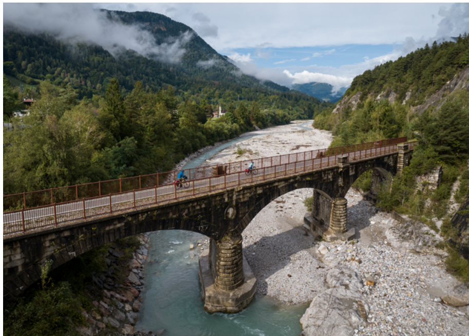
Via Pontebbana – jeden z piękniejszych wiaduktów na trasie.
