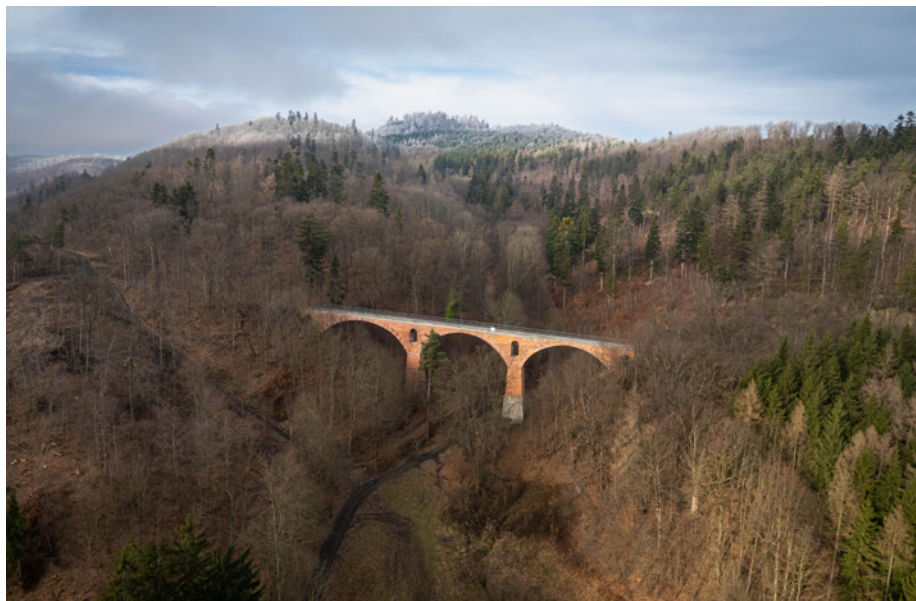
Wiadukt sowiogórskiej kolei zębatej
